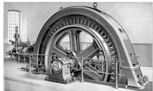
Abb 4.: Historischer Generator in einem Kraftwerk.
